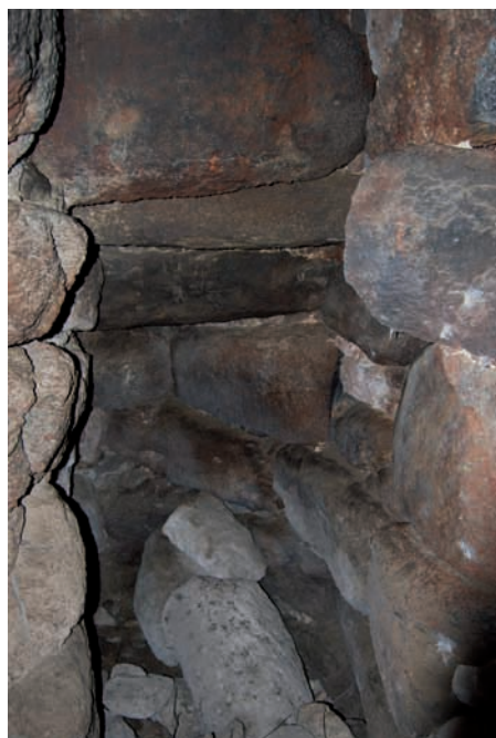
Nicchia d'andito (accesso alla scala del sotterraneo, oggi ostruita)
