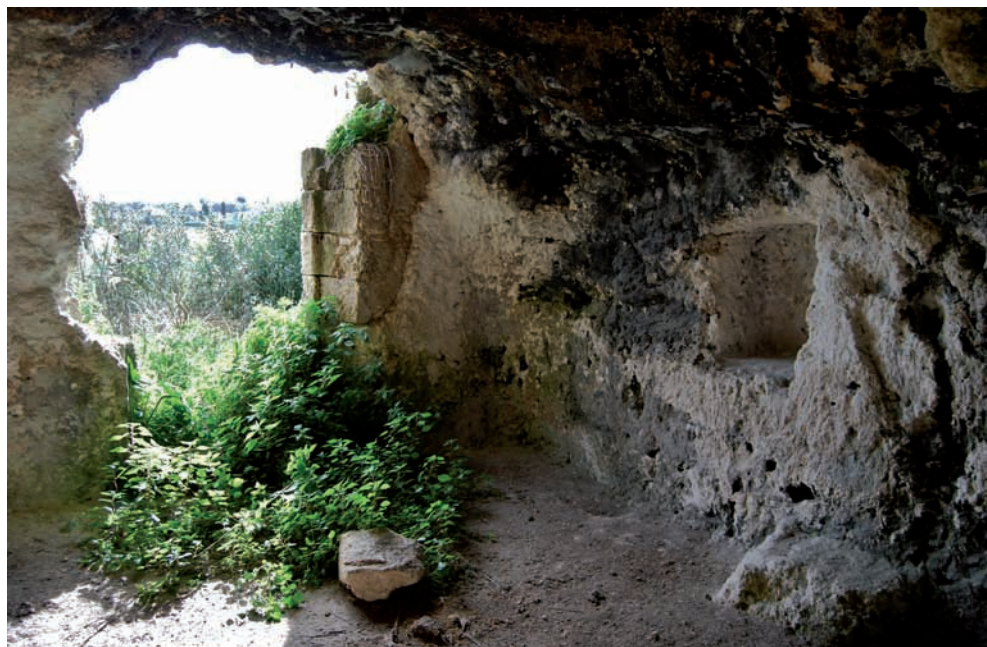
La parete di prospetto dall'interno
