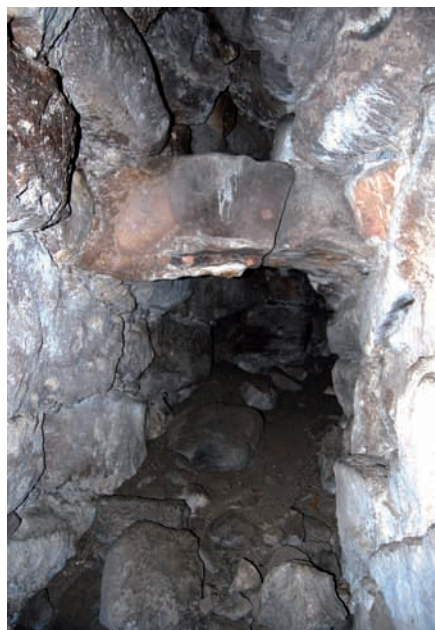
Un tratto del vano-scala, con architrave di rinforzo
