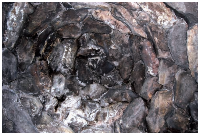
La tholos della torre centrale
