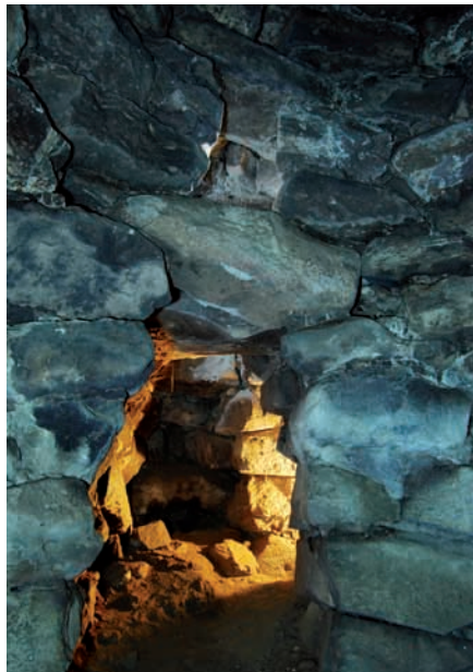
L'ingresso alla camera del mastio, dall'interno, sormontato dalla finestrella del vano sussidiario
