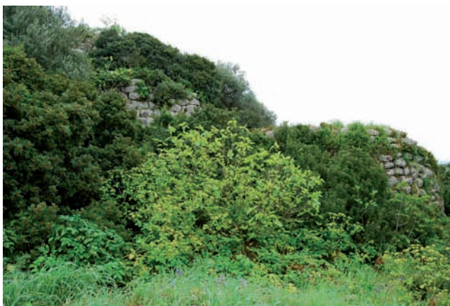
Veduta da Nord-Est
